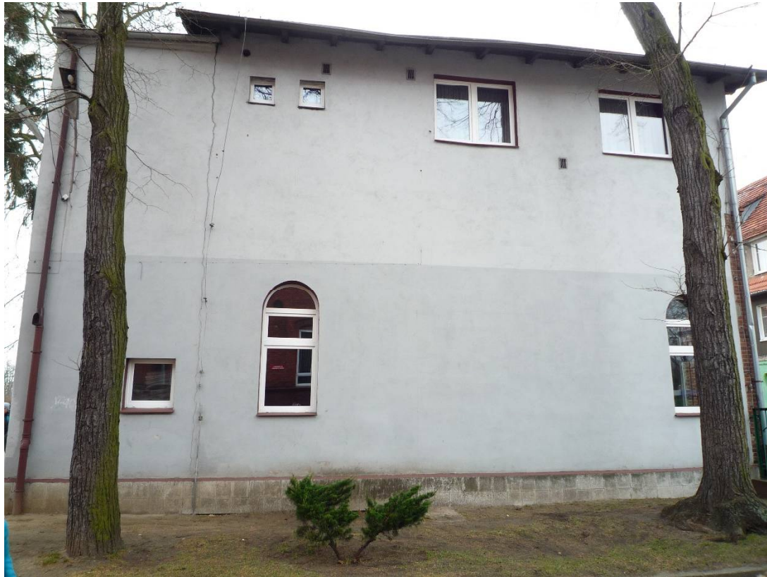
Budynek nr 5 -5 A
