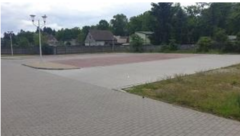
Budowa parkingu przy Kościele pw. Matki Bożej Fatimskiej
