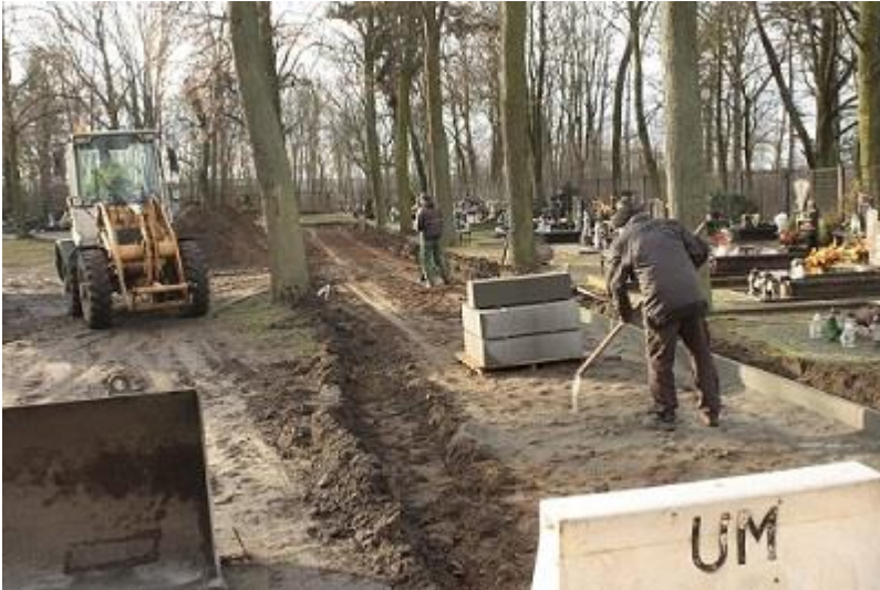
Budowa alejek na Cmentarzu Komunalnym – powierzchnia 750 m 2
