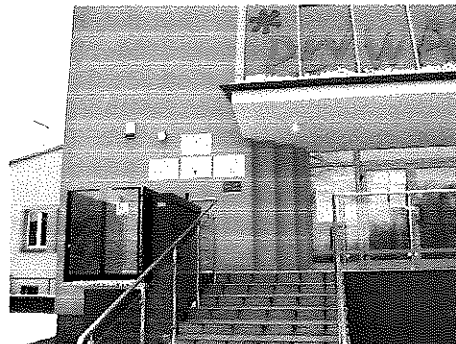
Zdjęcie nr 19: Hot Spot nr 2 – budynek Pływalni miejskiej w Gubinie
