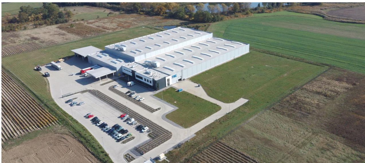
Widok terenów Podstrefy Gubin KSSSE przy ul. Legnickiej – rok 2019
